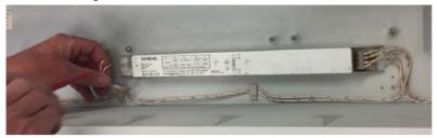
Schritt 1: Netzleitung "L" mit einer Leitung der Sicherung verbinden
